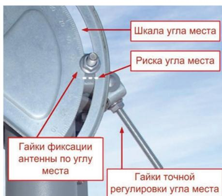
Установка расчетного угла места.
